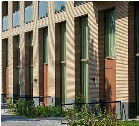
gevelarchitectuur accentueert begane grond
