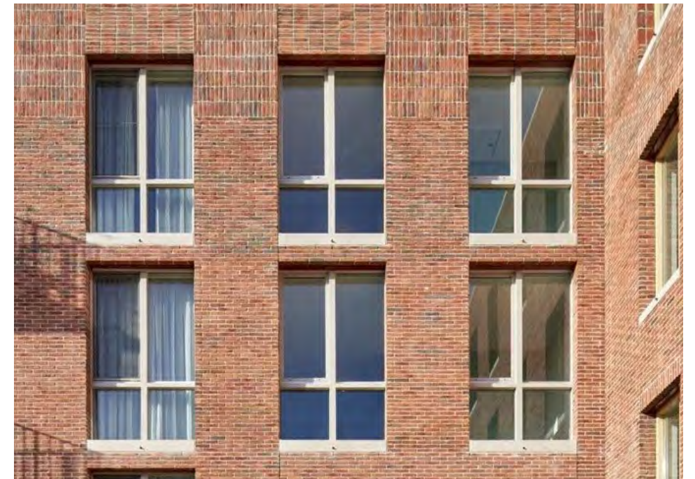
repetitie van gevelopeningen
