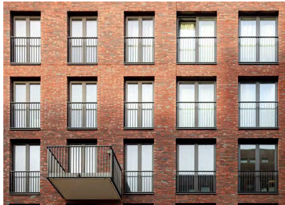
repetitie van gevelopeningen
