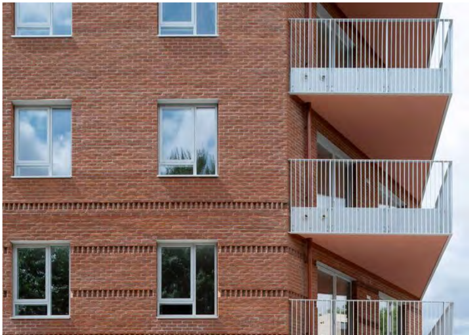
bruin rode baksteen met witte kozijnen
