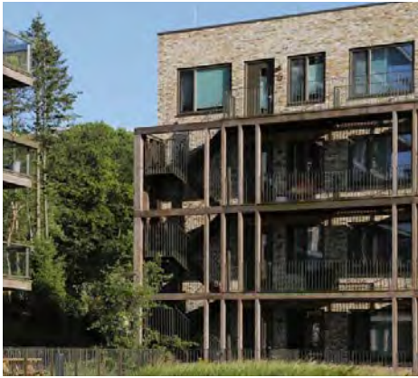
houten structuur tussen balkons
