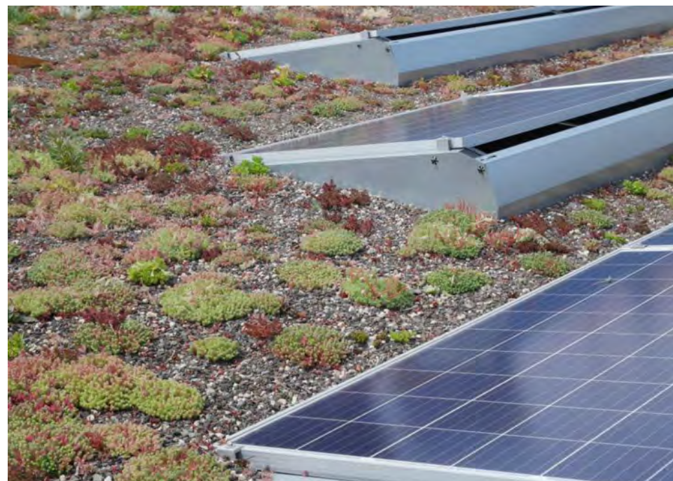
sedumdaken in combinatie met zonnepanelen
