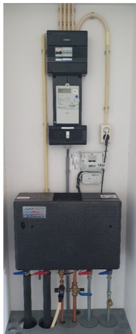
Afbeelding 4.4 – Een afleverset in een meterkast
