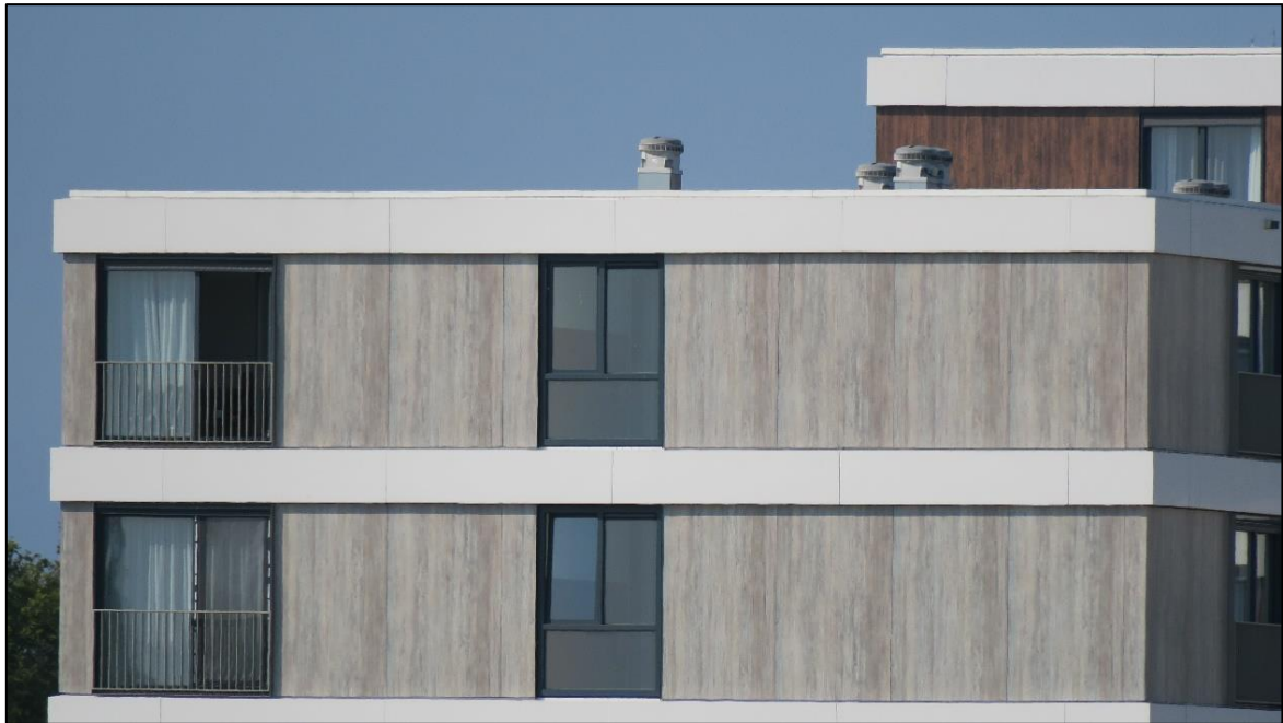
Figuur 3.1 De woonblokken in deelgebied 8 zijn opgetrokken uit verschillende materialen en bevatten geen luchtspouw of open dakruimte. Derhalve zijn vleermuisverblijfplaatsen hier uitgesloten.
