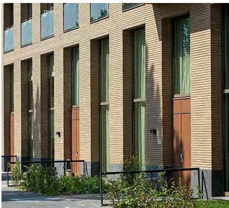
gevelarchitectuur accentueert begane grond
