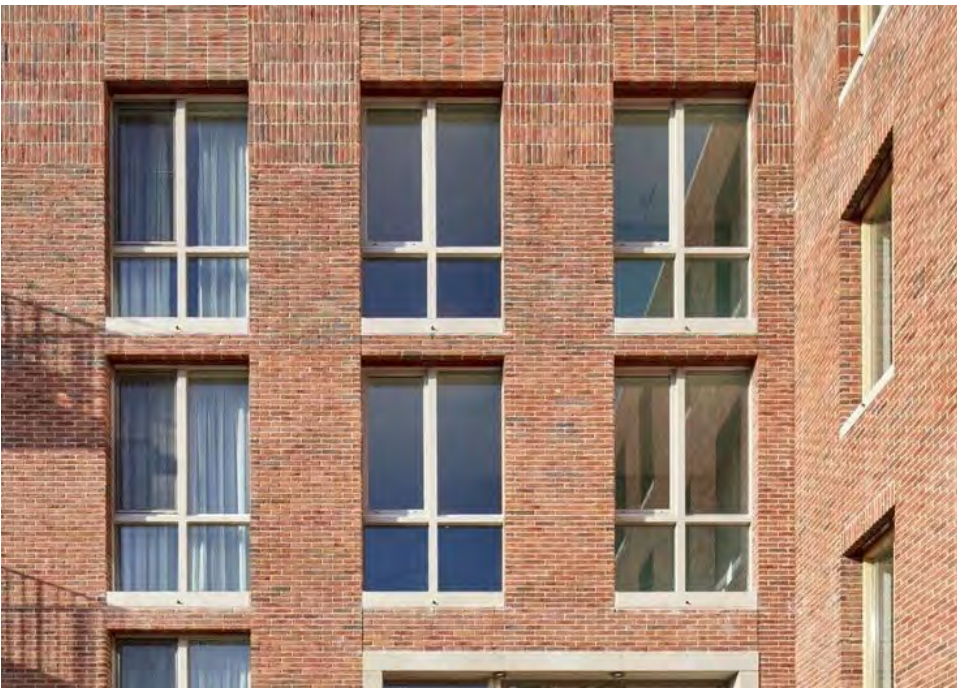
bruin rode baksteen met witte kozijnen
