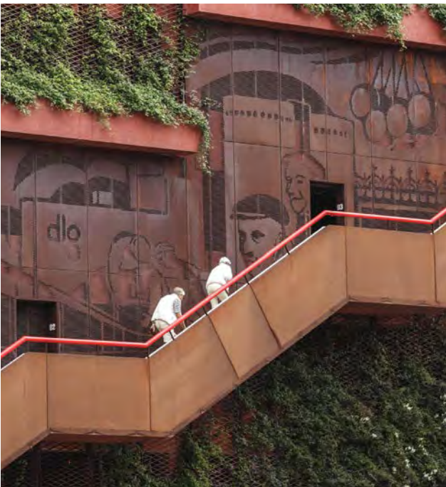
kunst als onderdeel van de gevel (geperforeerde staalplaat, keramiek)
