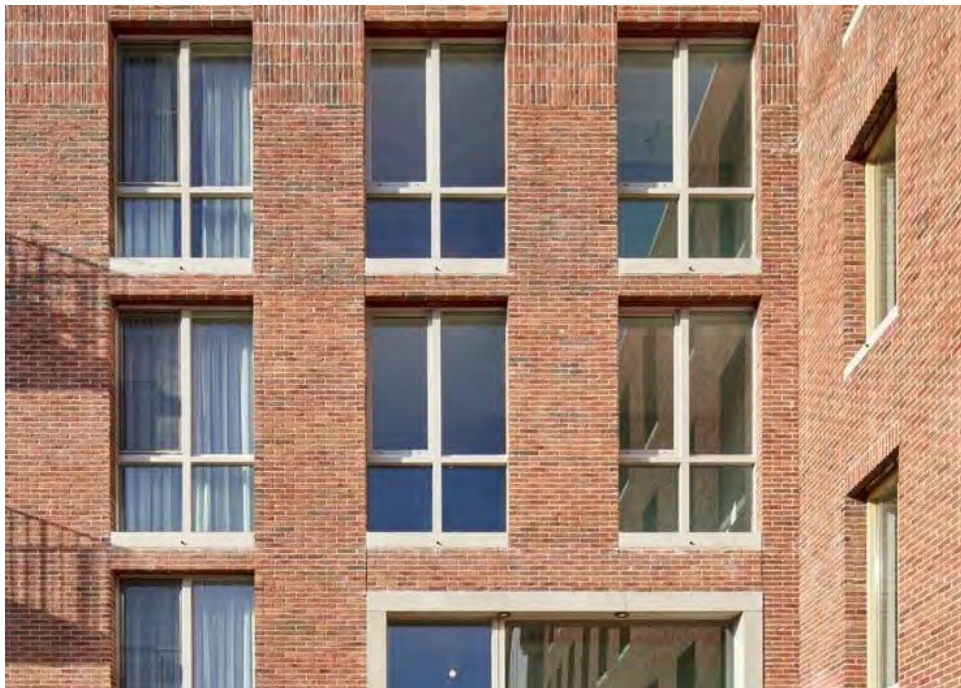
gevelvlak met uitsparingen
