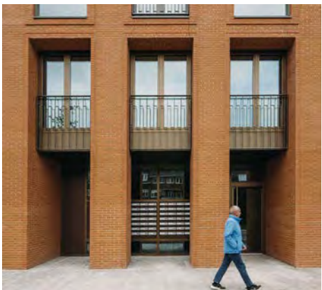
gevelarchitectuur suggereert hoge begane grond
