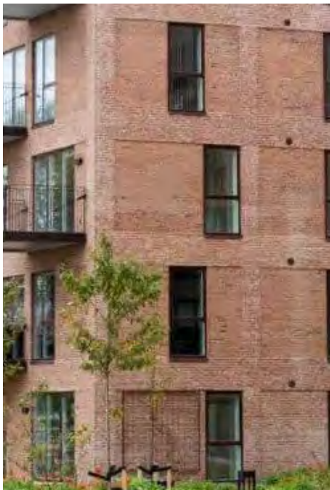
orthogonale gevelstructuur door reliëf
