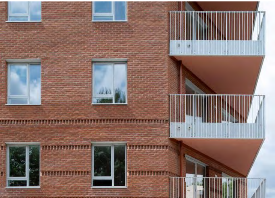
bruin rode baksteen met witte kozijnen
