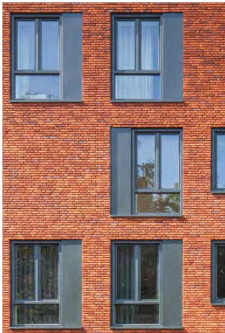
gevelvlak met uitsparingen
