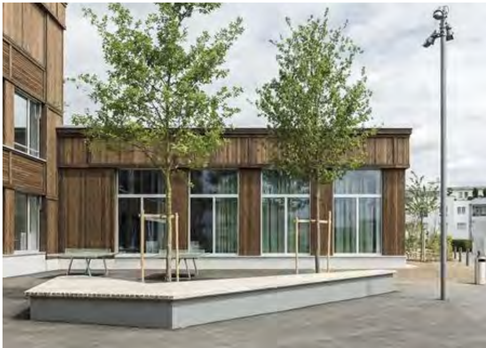
houten uitbouw van één bouwlaag
