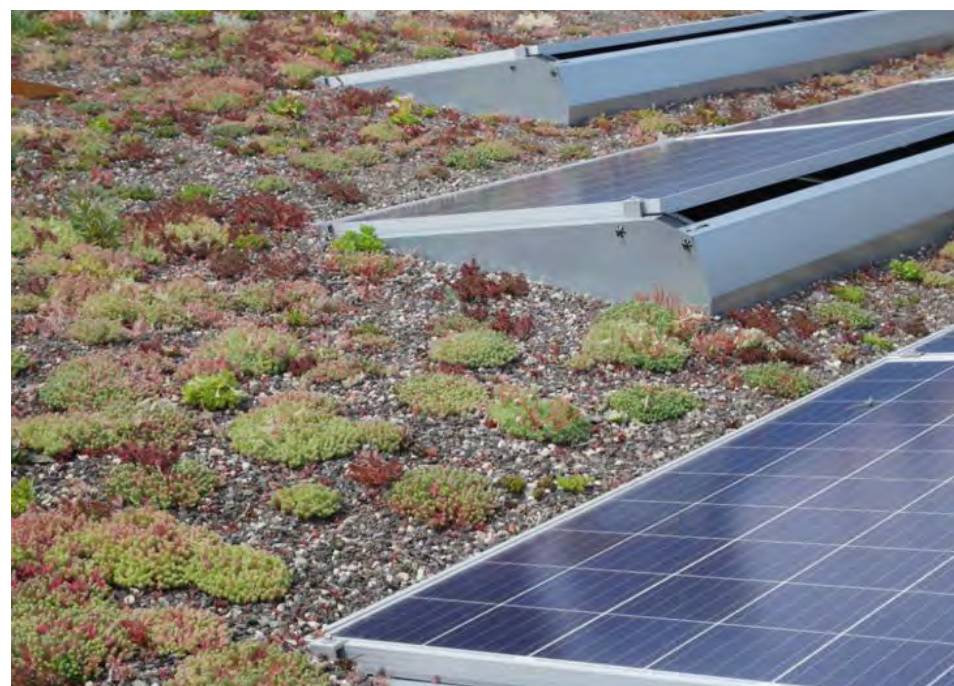
sedumdaken in combinatie met zonnepanelen
