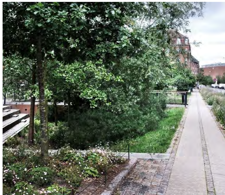
waterafvoer naar de raingardens
