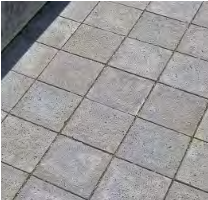
betontegels 20x20 cm in blokverband
