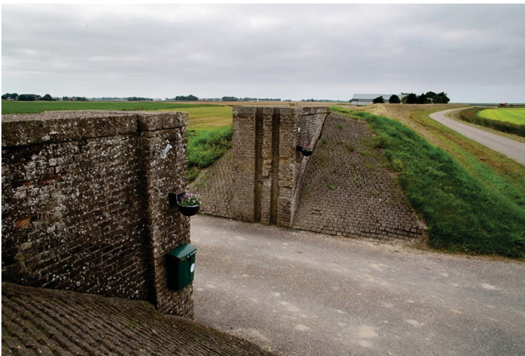
Figuur 5.11 Voorbeeld afsluiting dijkcoupure met schotbalken
