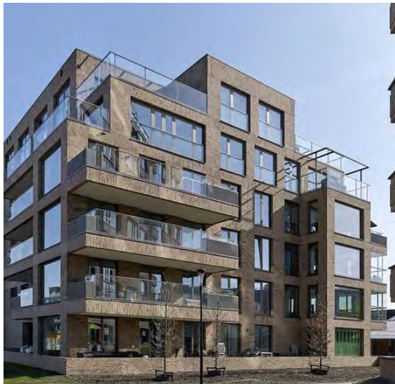
Bestrating tot aan de gevel De binnenzijde van het cluster is tot aan de voordeur bestraat grote pockets zijn voorzien van veel groen en waterretentie.
