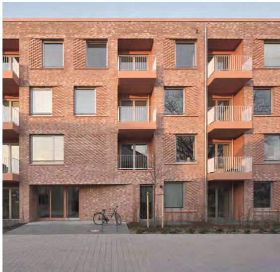
Monoliet gevel 1 In situ gemetselde baksteen geven de gebouwen een monoliet karakter.
