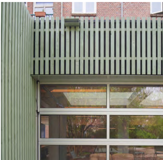
Add on's 4 Europees Douglas hout, brandwerend en gekleurd. Onderhoudsvrij.
