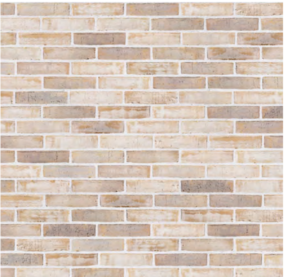
Baksteen 5 Baksteen licht kleurspectrum, halfsteensverband. Kozijnen in passende kleurstelling.
