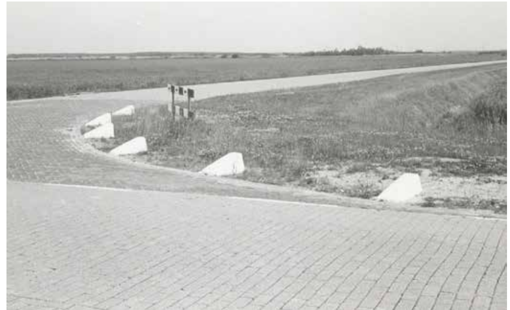
Afb. 12 1973, de Beginweg gezien vanaf het noorden.
