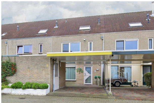
Figuur 2. Huizen in Karveel met pannendaken en dakgoten
